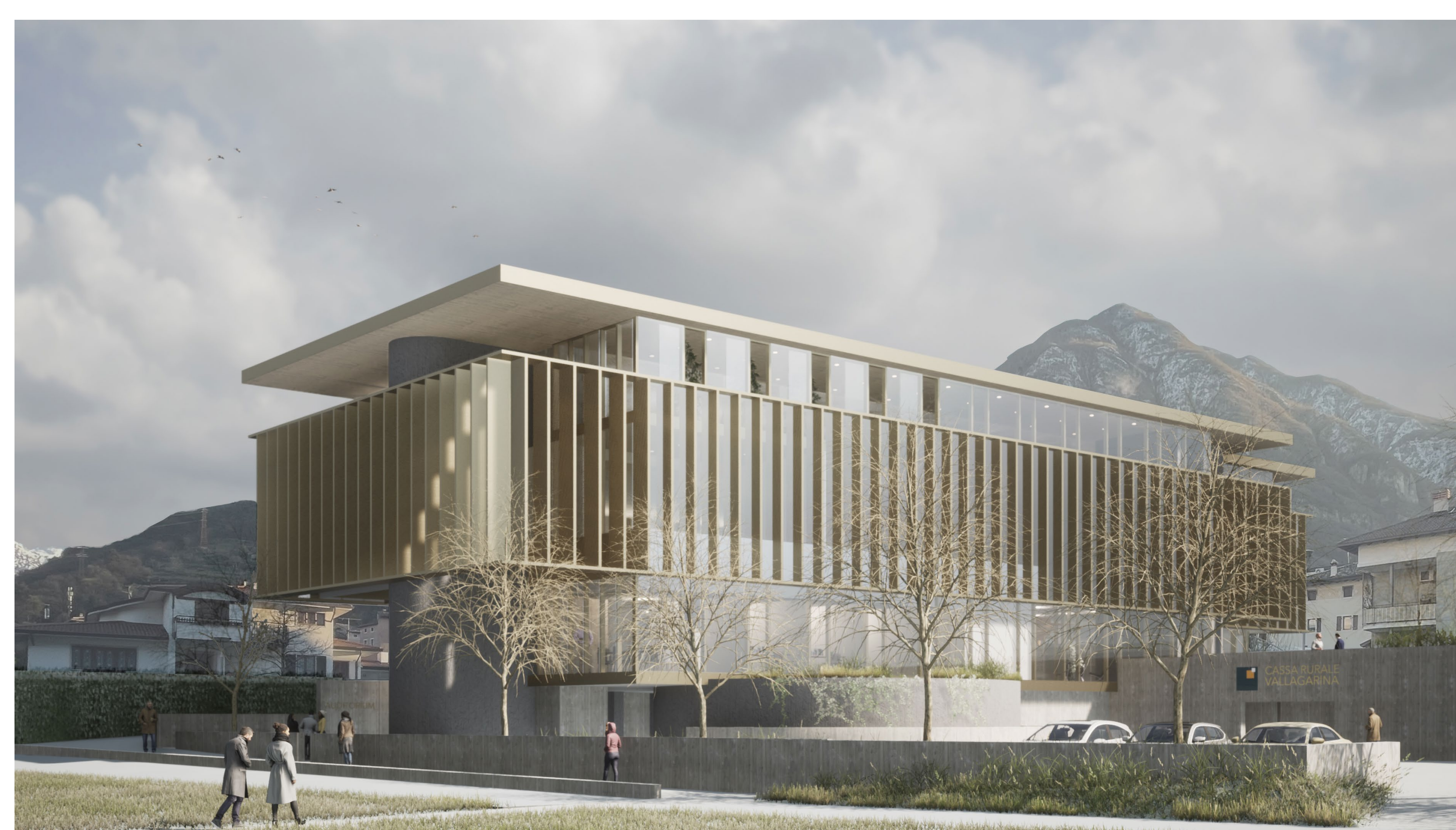
Vista lato parcheggio
